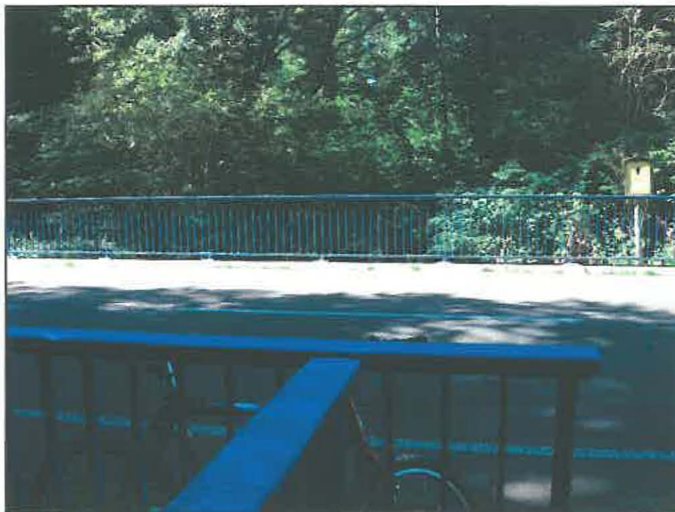
Abbildung 12: Blick von der östlichen Seite in den Auwald westlich an der Stobberbrücke.
