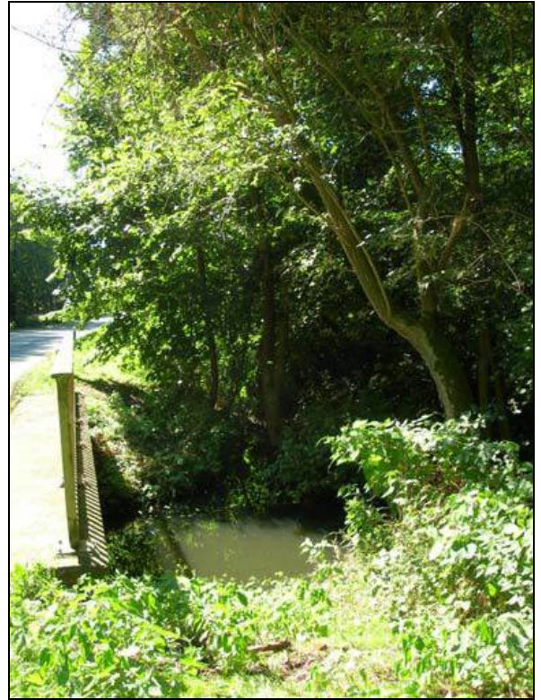
Abbildung 10: Seitlicher Blick an der Brücke südlich des Stöbbers. Hier wird sichtbar wie schmal der Saumstreifen für die Anlage eines Radweges in Höhe der Brückenbauwerke ist.
