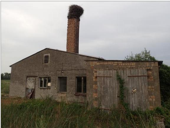
**Abbildung 15: Nebenbau mit Fugen in Schornstein, Lochziegel, Putzblasen (Punkt 1)**
